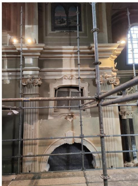
Descialbo paramenti murari della navata
